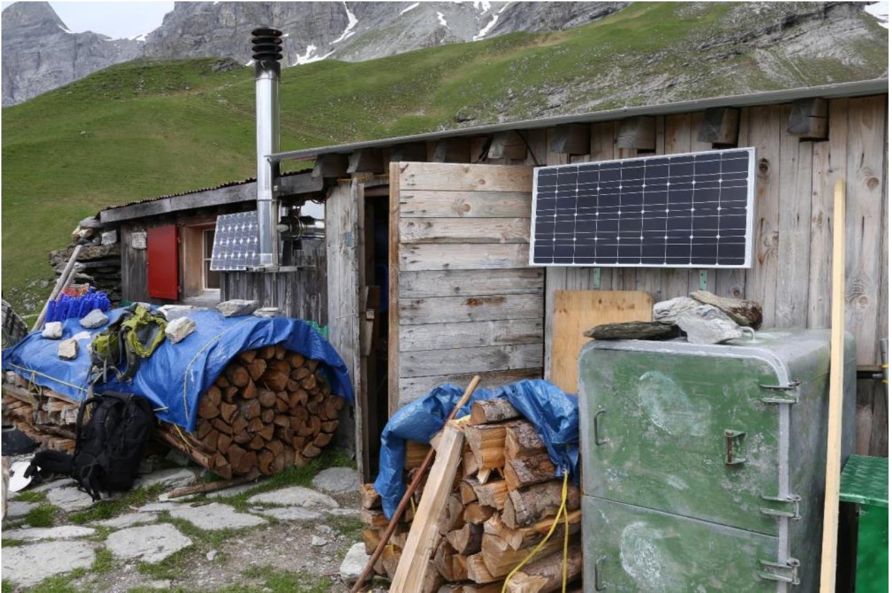
Obere Alphütte mit ausgebauter Solaranlage und neuem Kamin.
