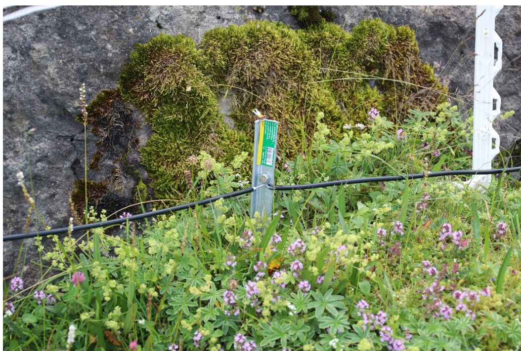
Massive und wirkungsvolle Erdung mit mehreren langen Eisen, dicker Drahtverbindung und verschraubten Kontakt-Verbindungen
