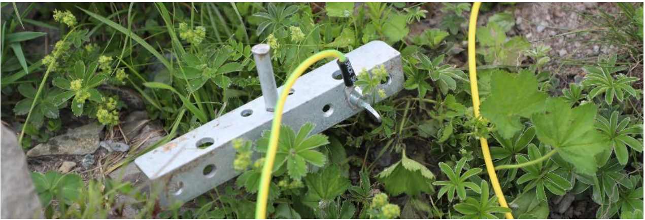
Sehr gute Mehrpunkt-Erdung mit verschraubtem Erdungskabel auf der Alp Mer
